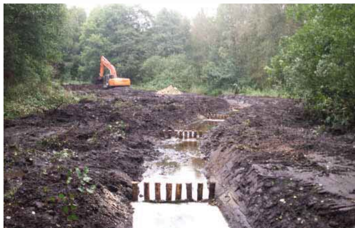
't Plat Aanleg vistrap
