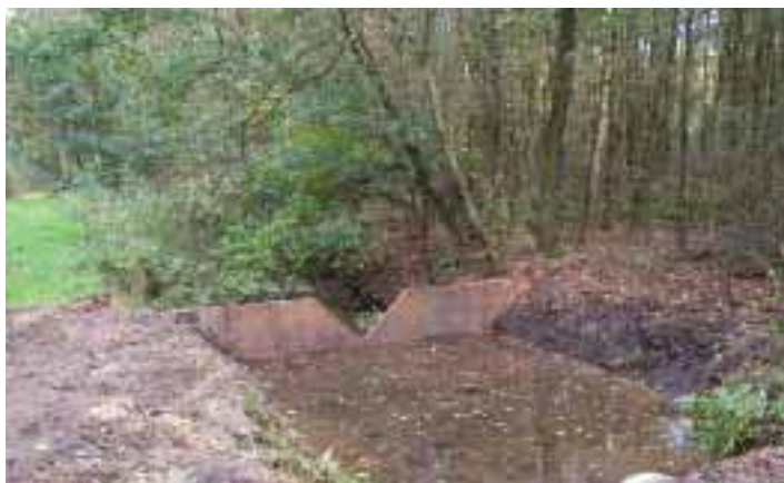
't Plat Sluis aan dijk
