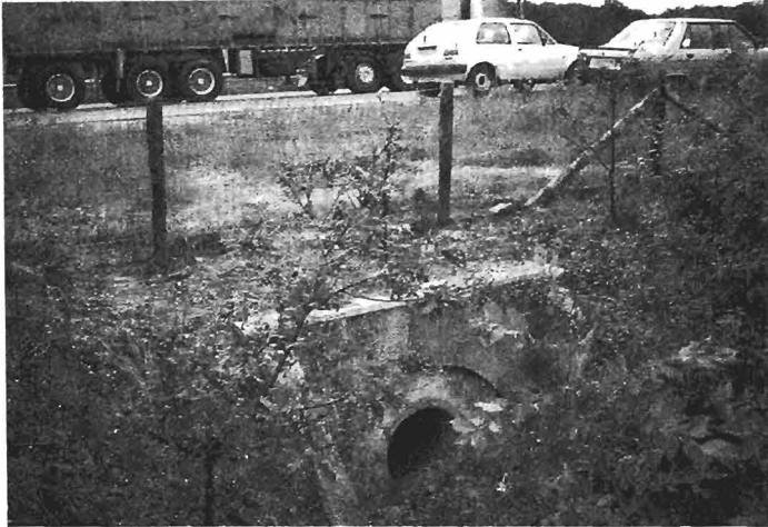
In het tracé zullen 16 dassentunnels worden aangelegd. Foto Roel Hoeve
