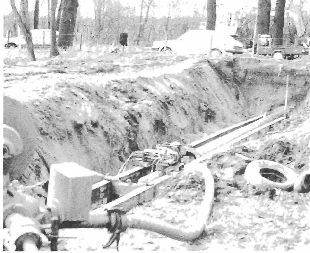
Een dassentunnel wordt onder de weg doorgeperst. Foto Hans Vink
