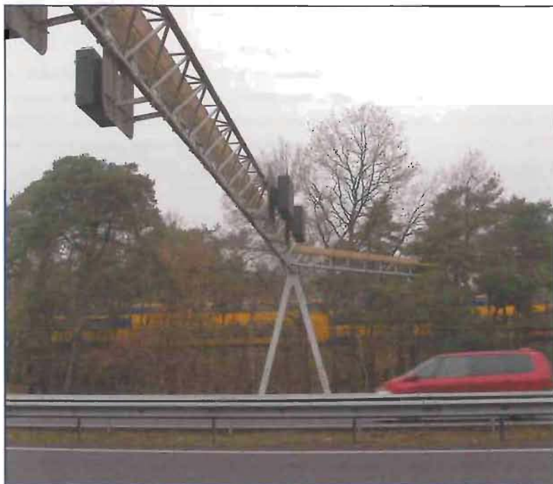
Een portaal met wegsignalering is geschikt gemaakt als boombrug. Foto: Erik Niewerf
