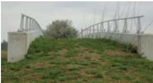
Figuur 6 Close-up van het ecoduct bij Nieuwstadt, Limburg.
