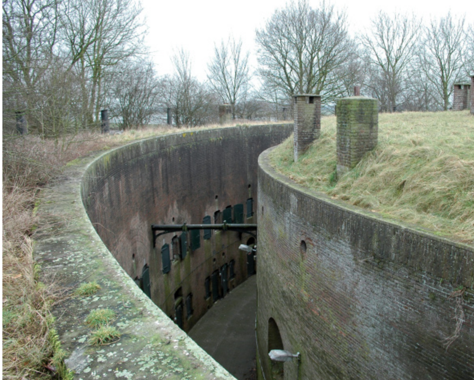
Toren en omliggende contrescarp van Fort Honswijk. Foto Bernadette van Noort
