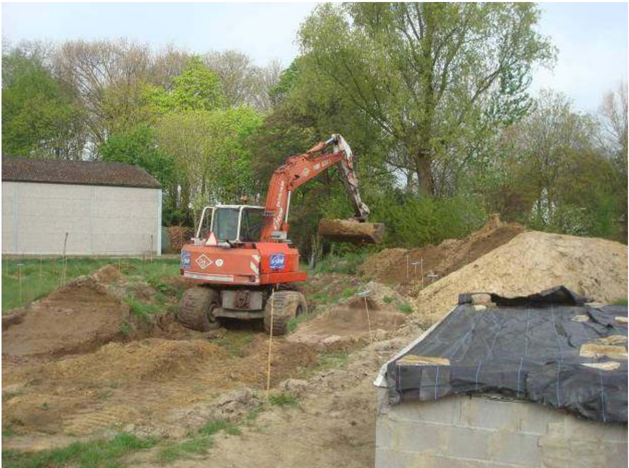
Belle kan starten met het graafwerk...
