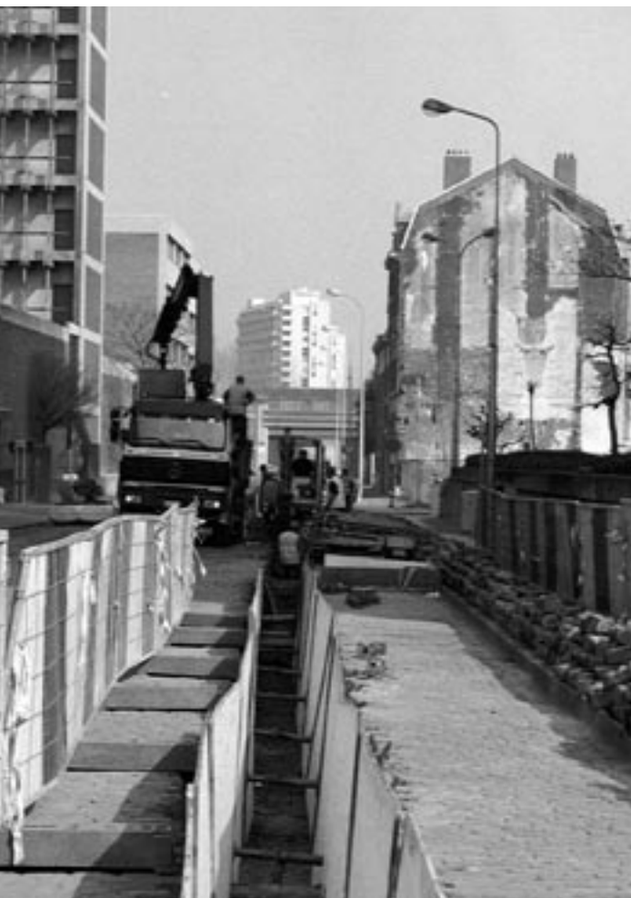
Wegenwerken in de Frontispiesstraat Foto: Caroline Van Malderen
