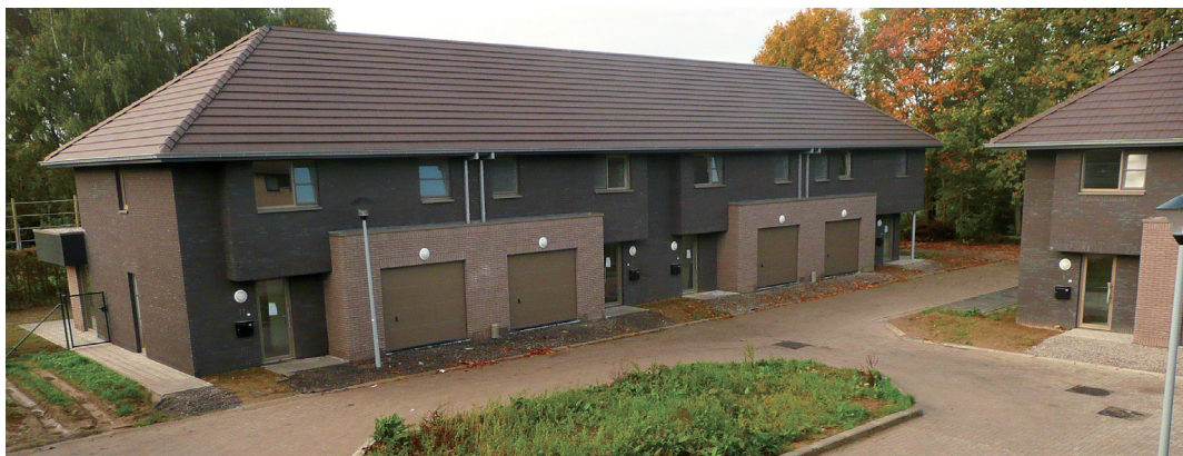
Weiland: 15 huurwoningen en -appartementen
