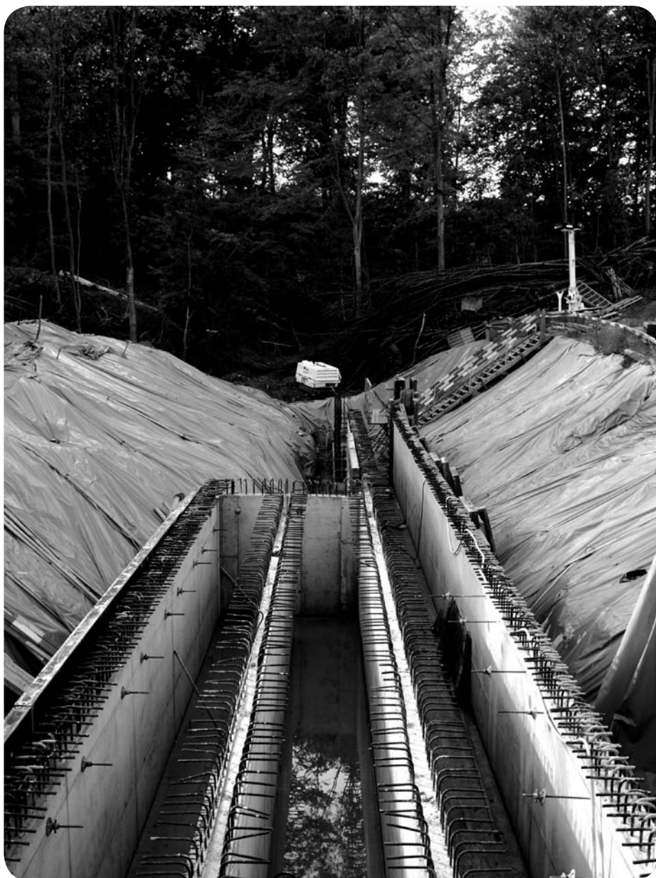
Infrastructure 3 en 1 faisant office de pertuis, de crapoduc et de nichoirs à chauve-souris
