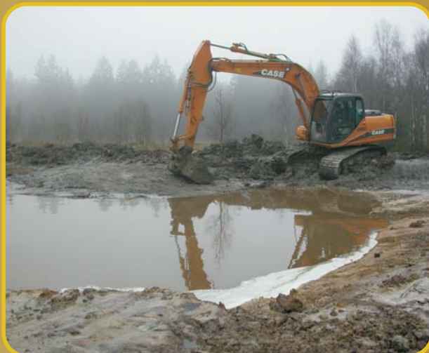
Mare creusée dans une coupe à blanc sur un haut-plateau ardennais. Les argiles ont été étalées autour de la mare et ont contribué à former une digue. Les berges sont adoucies à l'aide de la pelleuse.
