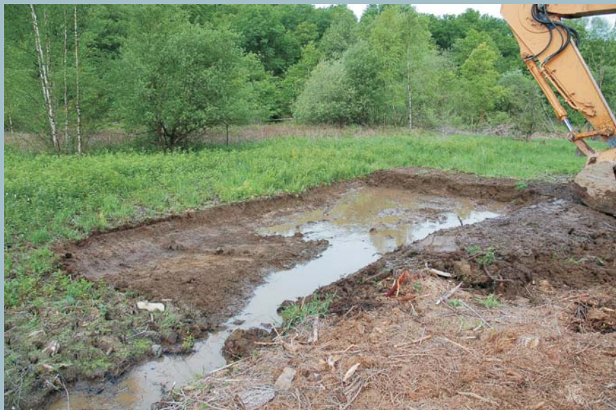
Bouchage d'un drain en bordure de mégaphorbiaie. Cliché Ch. Xhardez
