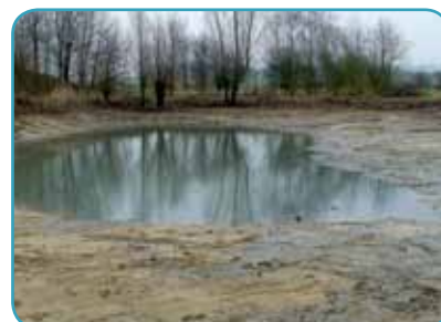
Photo 5 : Après étrépage et reprofilage des berges (03/2011).
