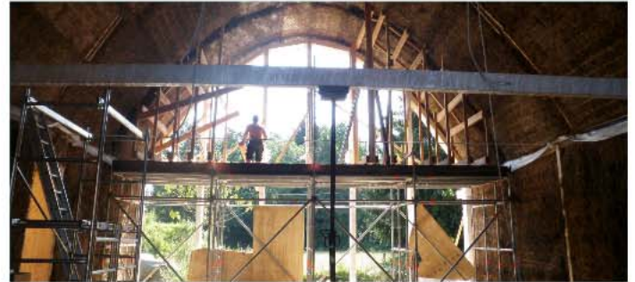
■ Construction d'une voûte auto-portante en bottes de paille
