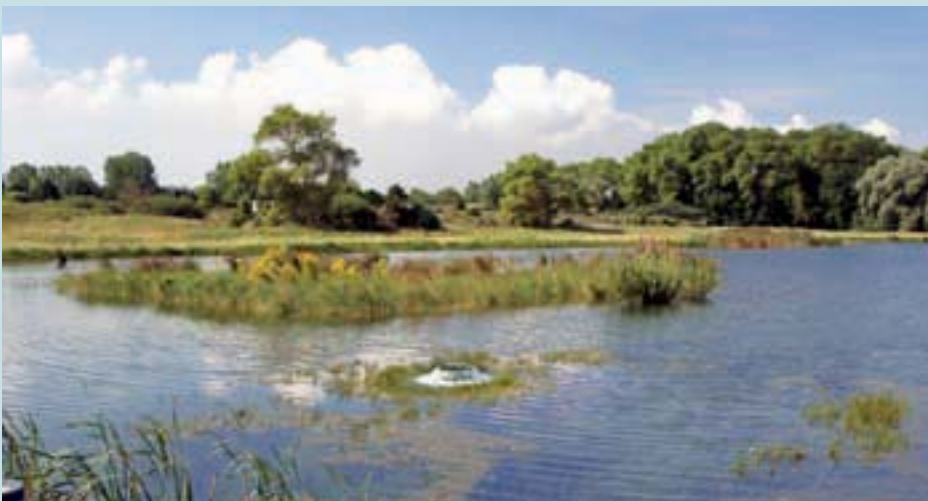
■ Zicht op het infiltratiepand van de waterwinning St-André te Koksijde. Centraal is de toevoer van water te zien. Via dit systeem wordt gezuiverd afvalwater terug in de duinen gebracht, waar het na passage door de duinzanden in opberbestoestand kan worden opgepompt en hergebruikt (AVDB)
