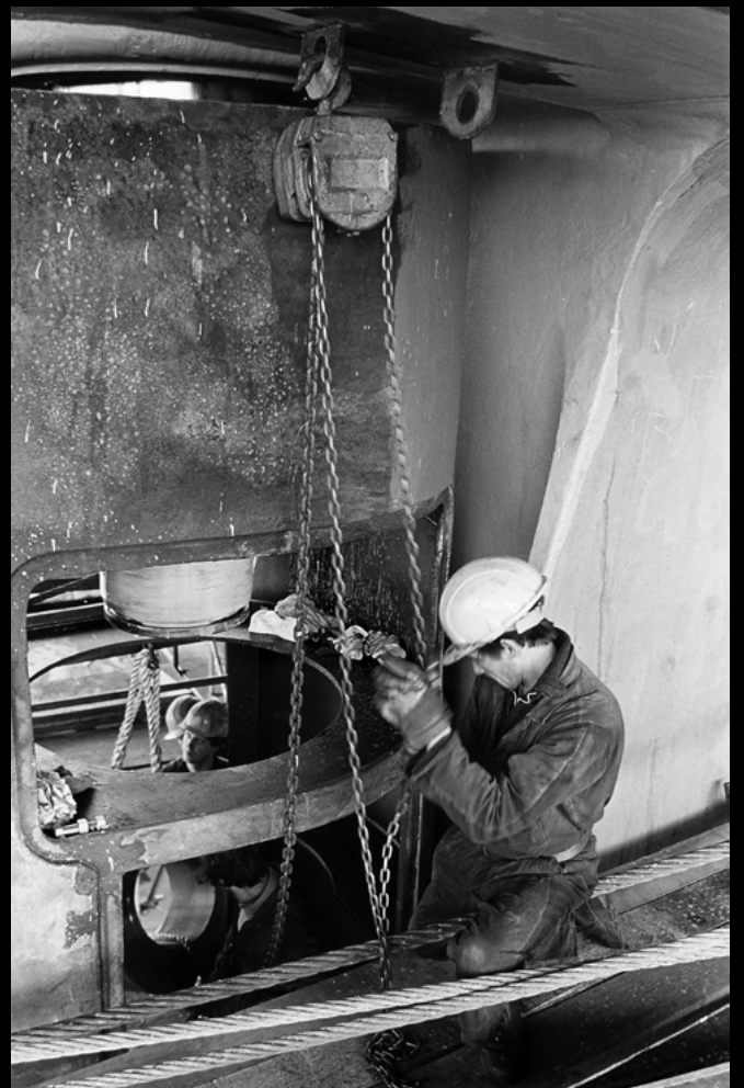
Paswerkers op de Boelwerf bij het monteren van een roer
