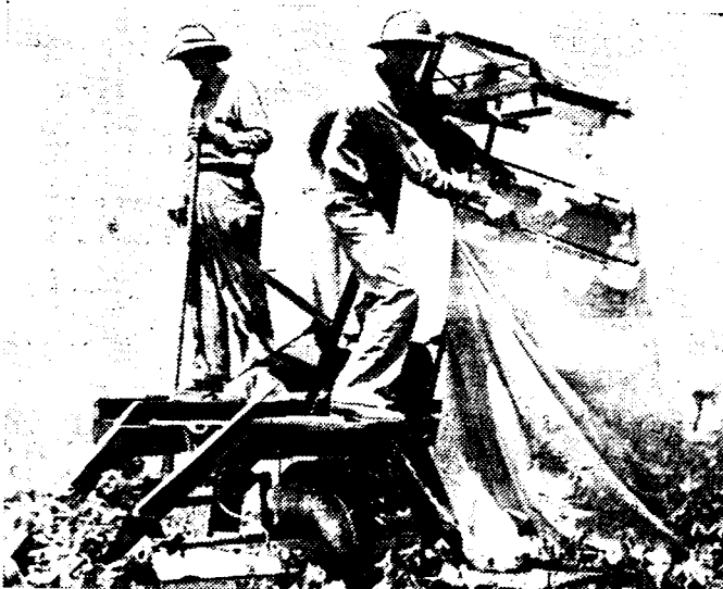
REVOLUTIE IN DE KATOENINDUSTRIE Een ware revolutie zal in de katoenindustrie teweeg gebracht worden, door de verspreiding dezer machine op de Amerikaanse katoenvelden. We zien ze hier in actie bij Stonerville (staat van Mississippi). De machine plukt het katoen en brengt het automatisch in zakken over
