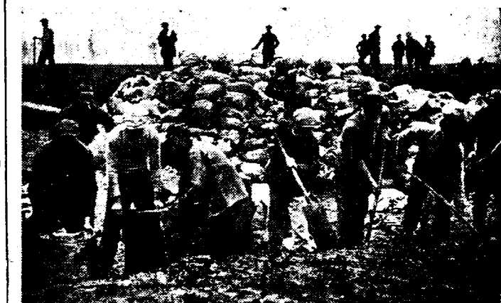
DE DIJKBREUK OP DE DURME TE WAASMUNSTER. Met gezamenlijke krachten hebben de bewoners van de streek tegen het gevaar van den waterloof gestreden. Honderden zandzakken werden als dam opgevoerd in de door het water ingebeukte dijkleuf.
