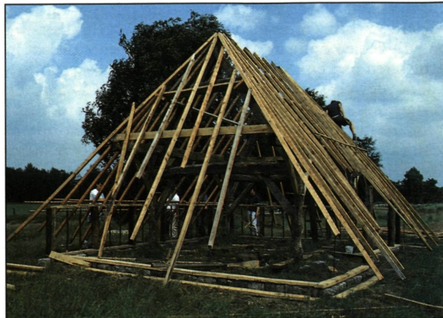
Kepers worden gelegd, achteraan links is men al begonnen met de wand
