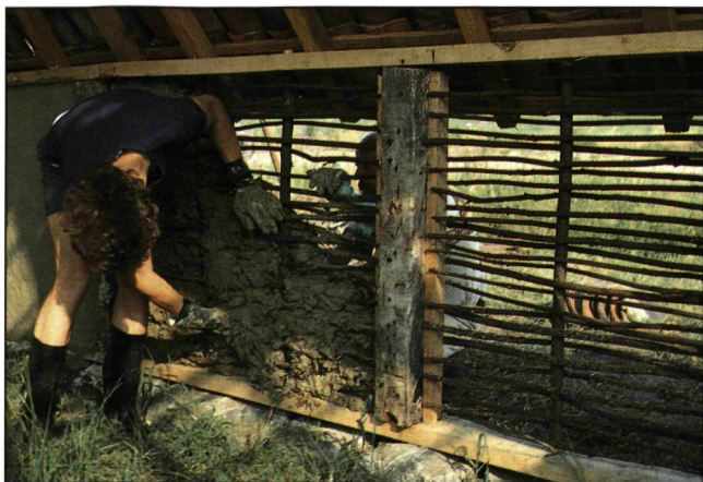
Van rechts naar links: het vlechtwerk, het lemen en een afgewerkt wandvlak. Foto: F. Van der Steen
