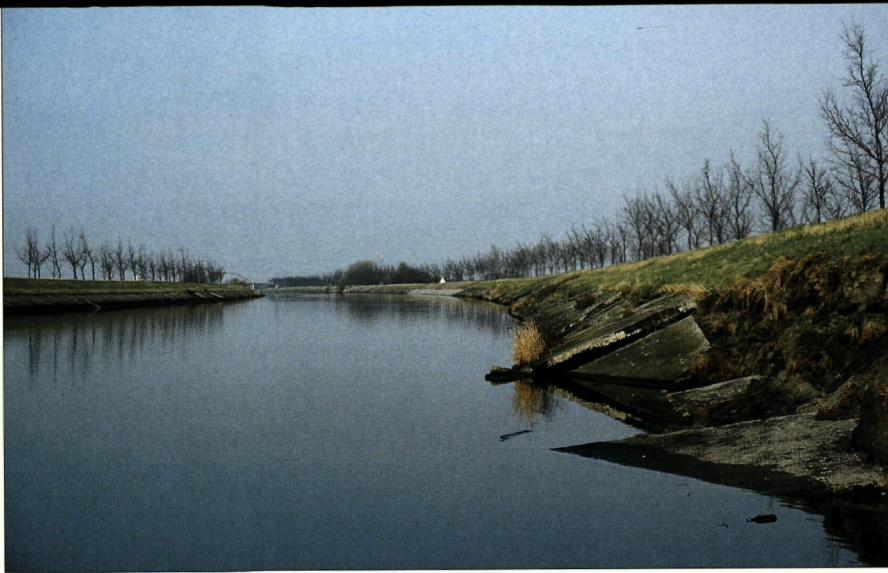
Natuurvriendelijke oever met plasberm. De Leie ter hoogte van Zulte. Voor en na de werken. (Foto: AWZ)
