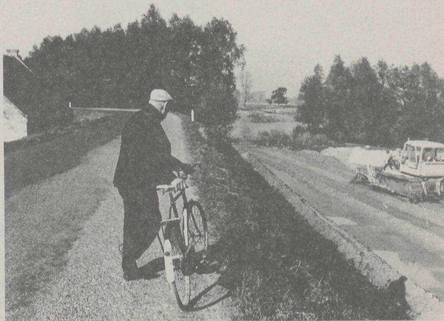
Is beter dijkonderhoud en dijkversteving de oplossing ?
