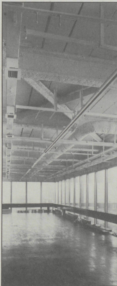
Stalen konstruktie bekleed met asbestspuitlagen
