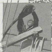
Plaatsing van lampen met laag stroomverbruik voor openbare verlichting
