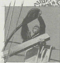
Plaatsing van lampen met laag stroomverbruik voor openbare verlichting
