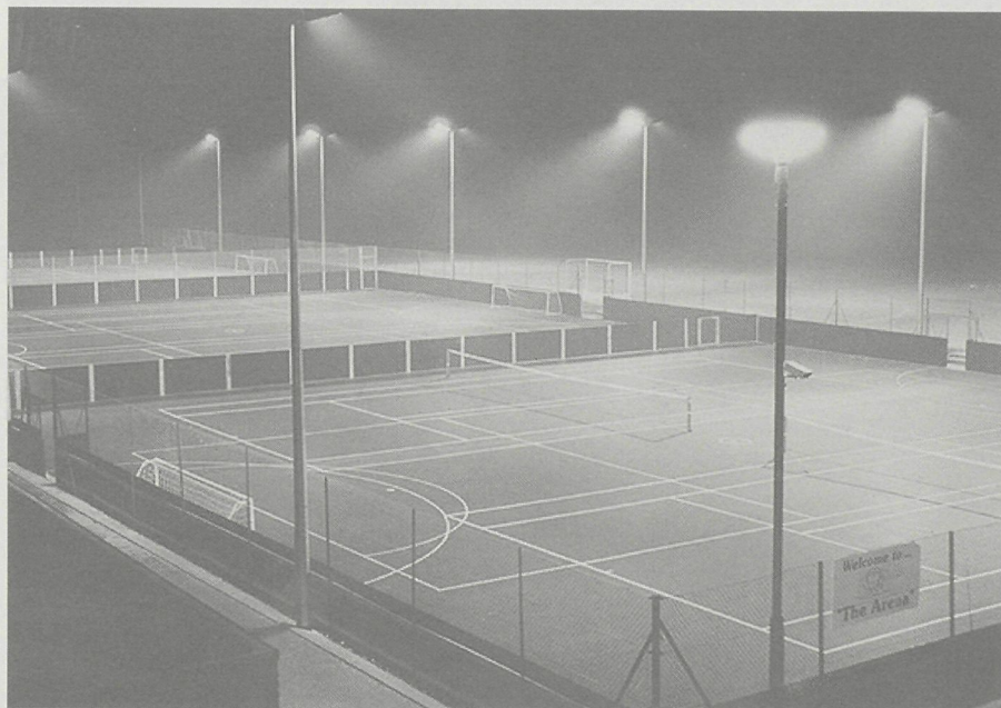
Een tennisveld dat verlicht wordt zoals het hoort: met armaturen die ervoor zorgen dat het licht gebundeld wordt zodat het niet breed openstraalt.
