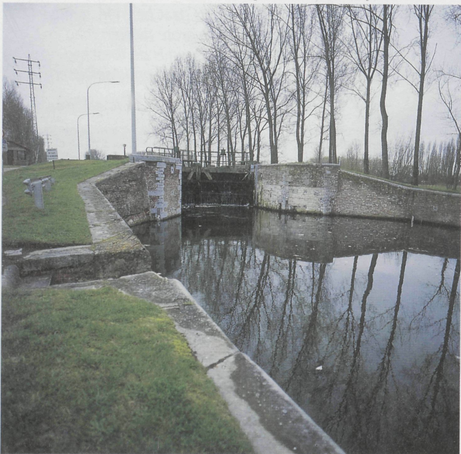
Stuwen en sluizen zorgen op veel plaatsen in Vlaanderen voor onoverbrugbare hindernissen voor vissen. Vissen worden erdoor opgezogen en gedood.
