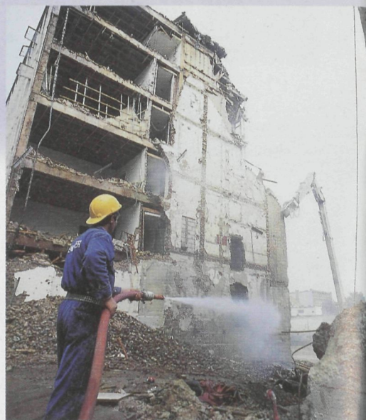
Het beukende gedreun van sloophammers of bulldozers...
