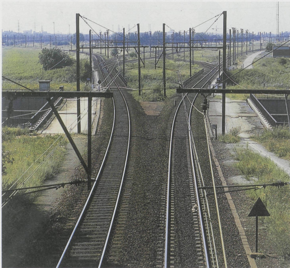
Dit is de 'muizenval' van het spoorverkeer van en naar de Antwerpse haven. Op deze spoorweg naar het goederenstation van Antwerpen-Noord passeert de helft van alle goederentransport van ons land. Een klein akkefietje en het volledige goederenspoorverkeer wordt in de war gestuurd...
