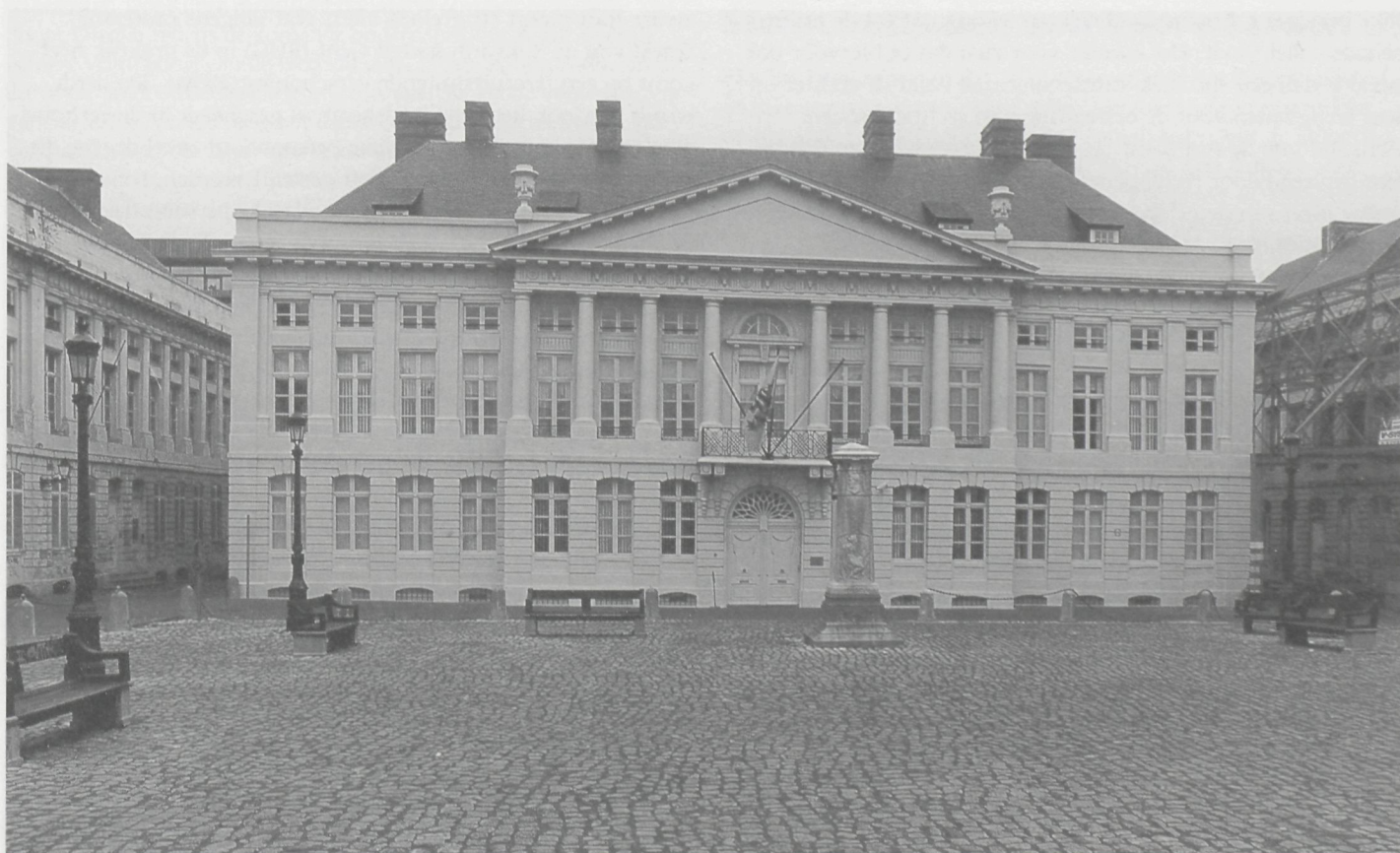
De gebouwen van de Vlaamse Regering op het Martelarenplein te Brussel zijn een goed voorbeeld van 'inbreiding'.
