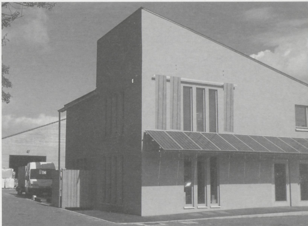
Het kantoor, de verkoopsruimte en het les- & vergaderlokaal van Ecobouw cvba zit in een compact en goed geïsoleerd geheel, de opslagruimte voor de materialen staat, los daarvan, een eindje achterin.
