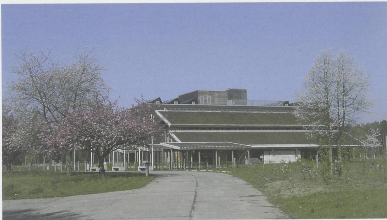
Kamp C in Westerlo, een voormalig militair kamp, werd omgebouwd tot een voorbeeldgebouw van wat een duurzame, energiezuinige woning kan zijn. Let ook eens op de groendaken, een oprukkende trend in het milieubewust bouwen.
