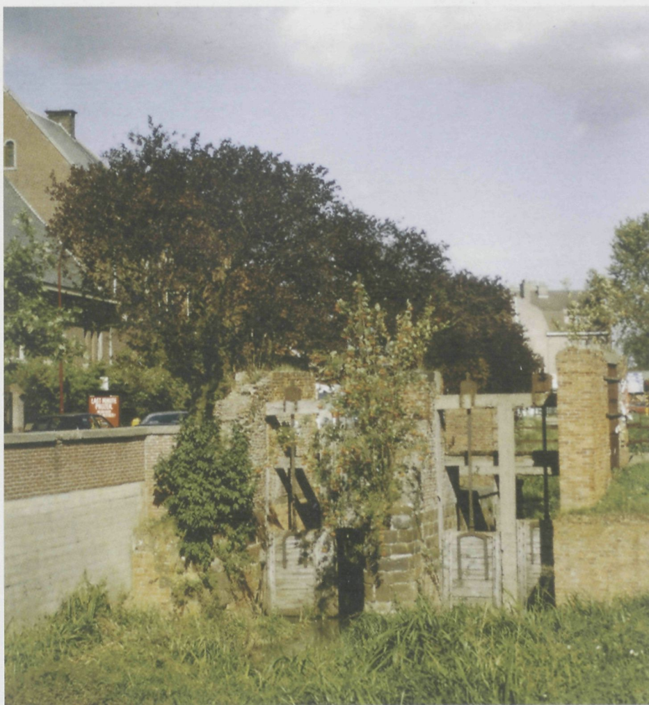
Het 'Saske', een sluizensysteem op de Laak in Aarschot. De restauratie van dit 'Saske' is een sleutelproject in de herwaardering van de Laak. Het Regionaal Landschap Noord-Hageland is met dit project al heel lang bezig ...
