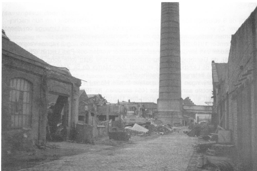
Het begin van de afbraak van de productiehallen na sluiting van het bedrijf
